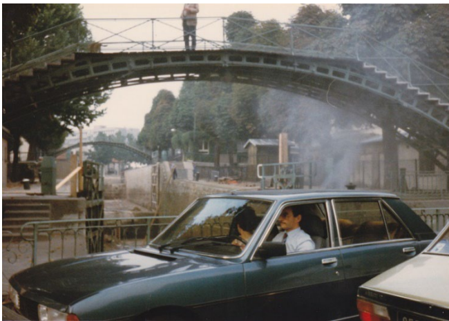
北ホテル前の運河にかかる跨線橋
